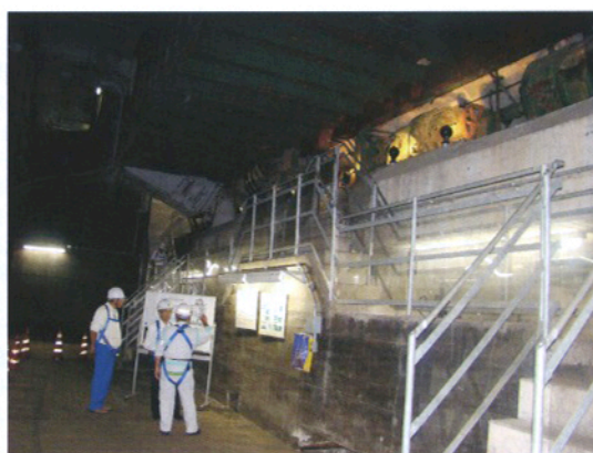
橋脚内の空間には昔の機械設備が残っています
